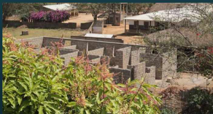
7) Realizzazione muri interni ed esterni
