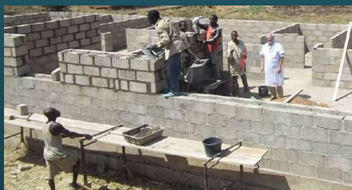
6) Realizzazione muri interni ed esterni
