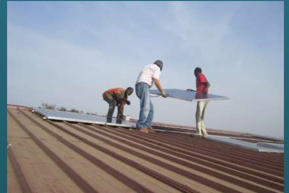
12) Installazione pannelli solari
