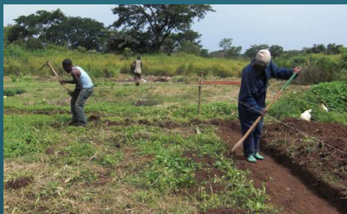
3) Preparazione del terreno per le fondazioni
