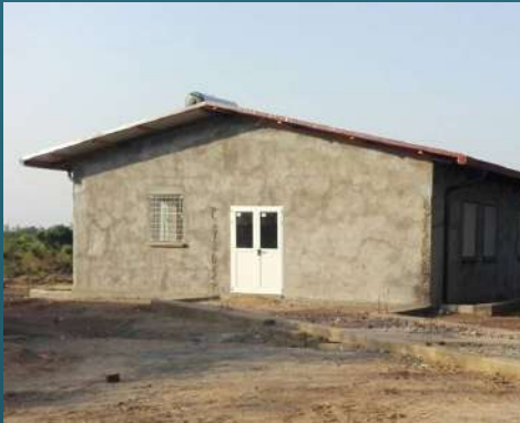
10) Posa copertura e infissi
