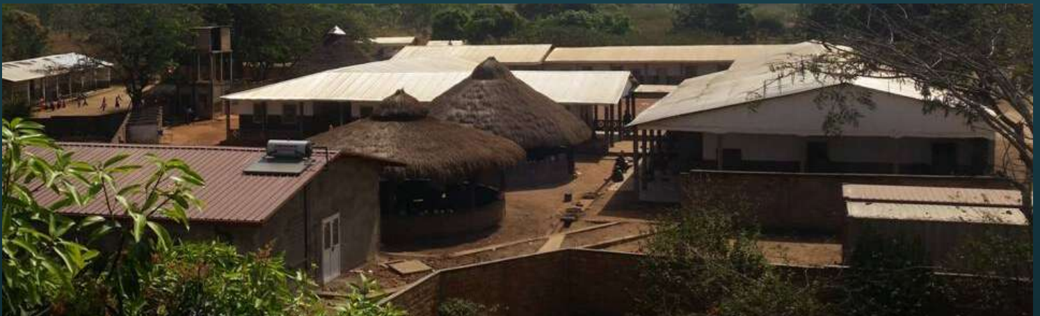
16) Veduta dell'area del Dispensario di Niem (Prima della realizzazione del corridoio di collegamento tra il blocco operatorio e la struttura esistente)
