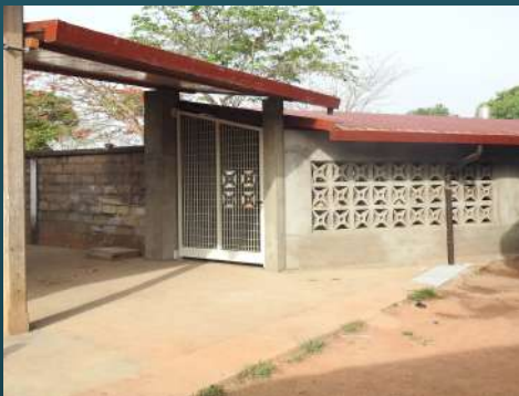
13) Ingresso blocco operatorio
